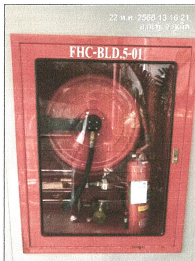
รูปภาพที่ 2.29 ตู้สายฉีดน้ำดับเพลิง (FHC)
